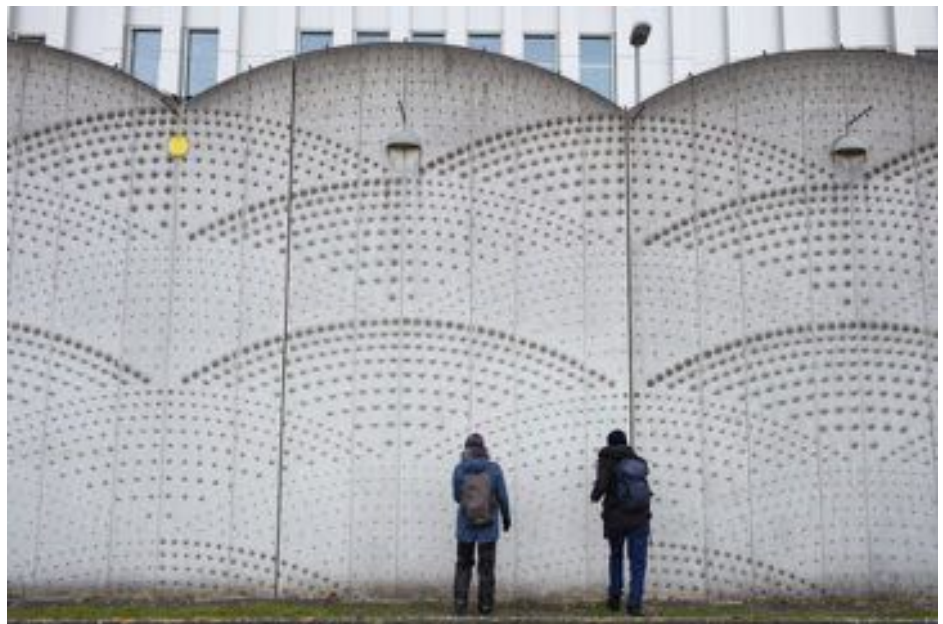
Bij de muur van het Justieel Complex Schiphol.
